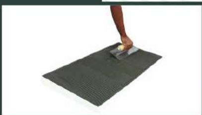
چسب آرمکس را با استفاده از ماله دندانه دار بر روی تمام سطح پشتی صفحه عایق به صورت شبیاردار اعمال می‌گردد.
