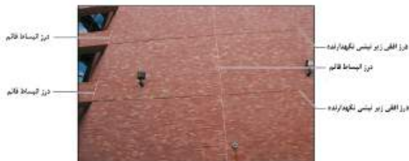
شکل ۵-۱۷- درز انبساطی پیوسته در نمای آجری
