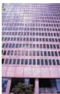
شکل ۱۰-۱- نمای ساختمان ساخته شده با پانل‌های بتنی پیش‌ساخته
