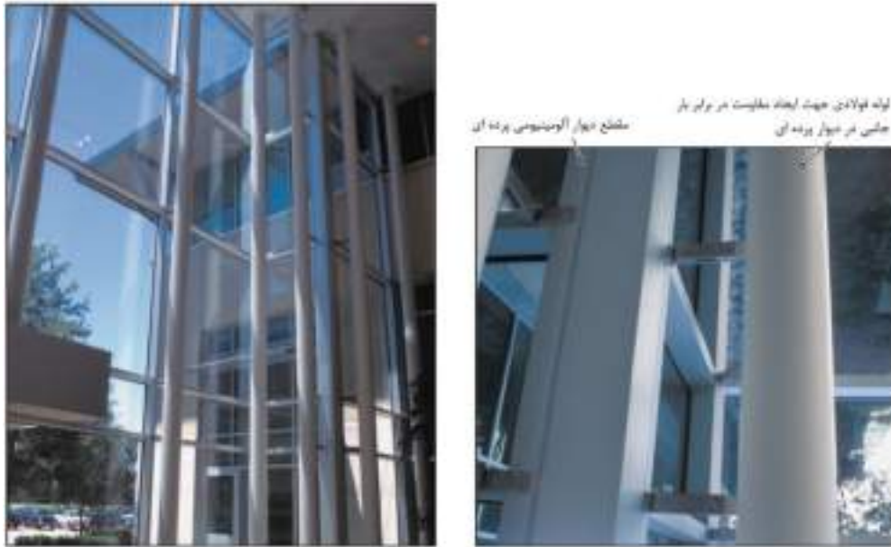
شکل ۹-۲۱- نمای پرده‌ای بلند، جهت تامین مقاومت جانبی به قاب فولادی سازه متصل شده است
