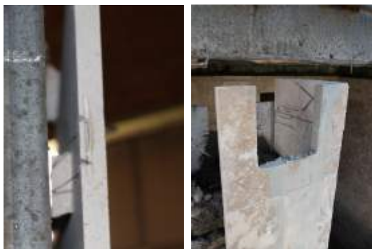
شکل ۴-۲- نمونه‌هایی از مه‌ارهای سیمی فولادی
