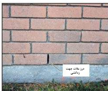
شکل ۵-۱۳- خالی گذاشتن درز ملات جهت زه‌کشی
