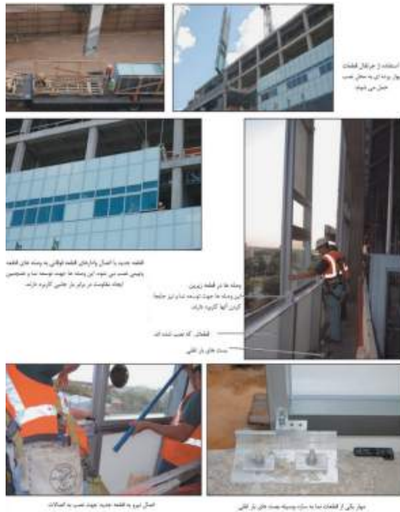
شکل ۹-۱۲- مراحل نصب نمای پرده‌ای یکپارچه
