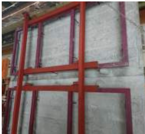
شکل ۱۱-۱۳- نمونه‌هایی از لایه پیوندی و مهارهای انعطاف‌پذیر
