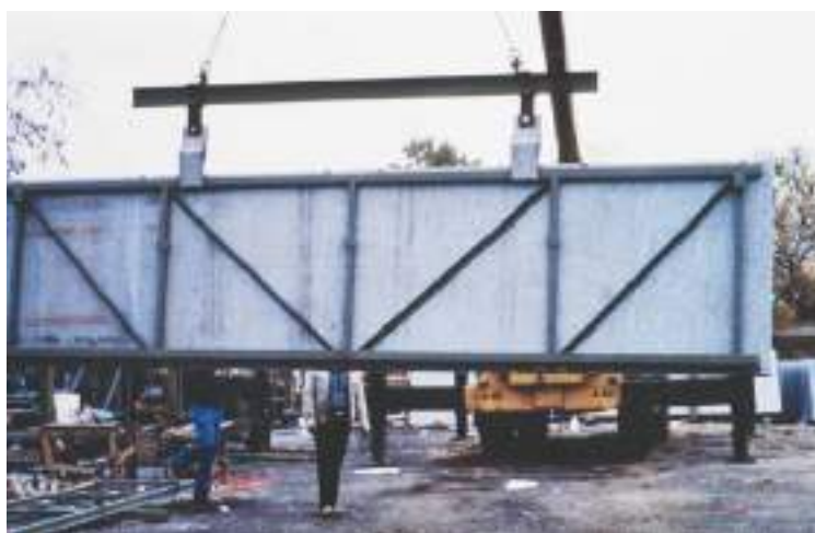
شکل ۴-۲۱- پانل دیواری پرده‌ای پیش ساخته سنگی
