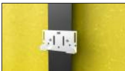
۲- نصب کلیپس‌های تحتانی بر روی پروفیل‌های قائم
