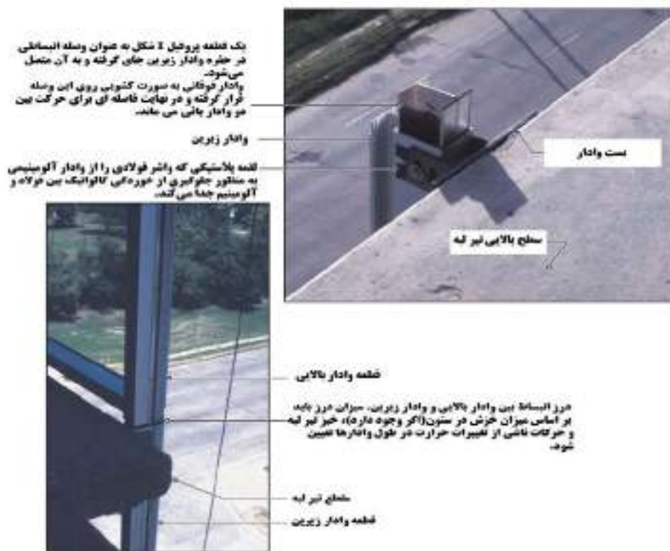
شکل ۹-۷- نمونه اتصال انبساطی بین دو قطعه وادار
