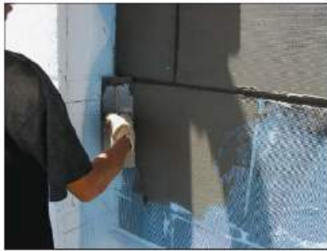
شکل ۱۱-۷- اجرای لایه‌های پوششی
