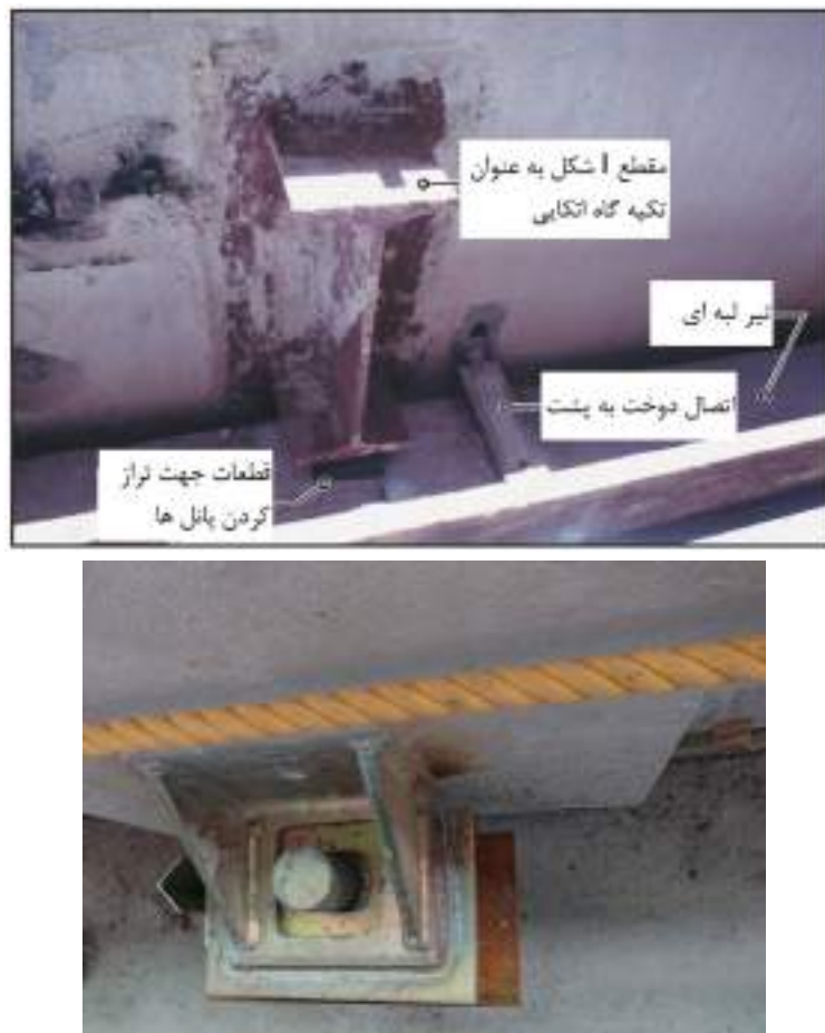
شکل ۱۰-۶- نمونه هایی از عناوین تکیه گاه اتکایی در پانل های بتنی پیش ساخته
