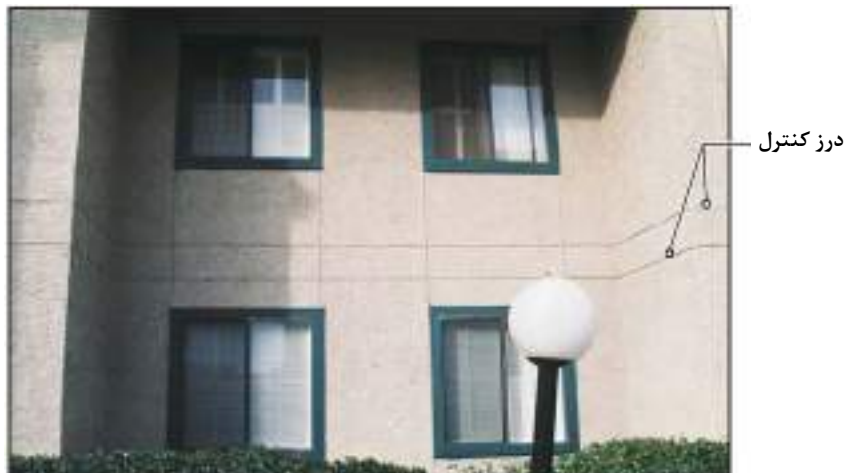
شکل ۶-۲- نمونه درزهای کنترل بر روی نمای سیمانی
